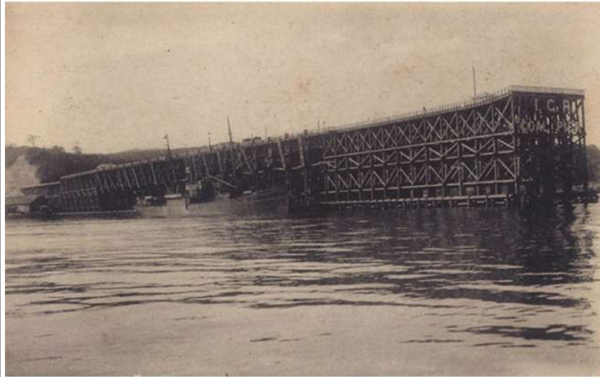
高架棧橋と石炭積み込み中の貨物船。この構造、大きさの高架棧橋は、室蘭港にも同時に建設された。高架棧橋は昭和19年(1944年)まで稼働後、解体された。木製のための腐朽、戦争末期の空襲目標となることを避けた、など理由は諸説ある。海中に打ち込まれた基部は昭和30年(1955年)ころまで残っていた。(撮影:大正時代、小樽市総合博物館)
