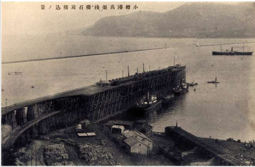
増加する石炭輸送への対応で建設された高架棧橋。明治44年(1911年)竣工。長さ289メートル、海面からの高さ19メートルの巨大な木造施設で、じょうご状の設備を使って貨車から貨物船に石炭を流し込んだ。(撮影:大正時代、小樽市総合博物館)
